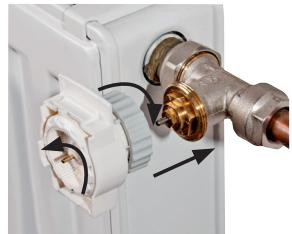
4. Uchopte těleso hlavice displejem směrem nahoru, zkонтrolujte zda páčka západky směruje také vzhůru. Potom těleso naklapněte z vrchu dolů na ventil s převodovou částí.
